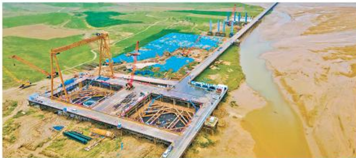
跨黄河特大桥施工现场俯瞰图
