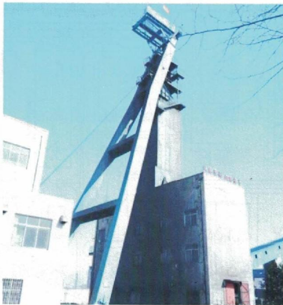
图 2.1-4 矿区西一风井井口
