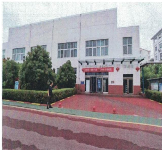
图 2.1-7 矿区职工餐厅
