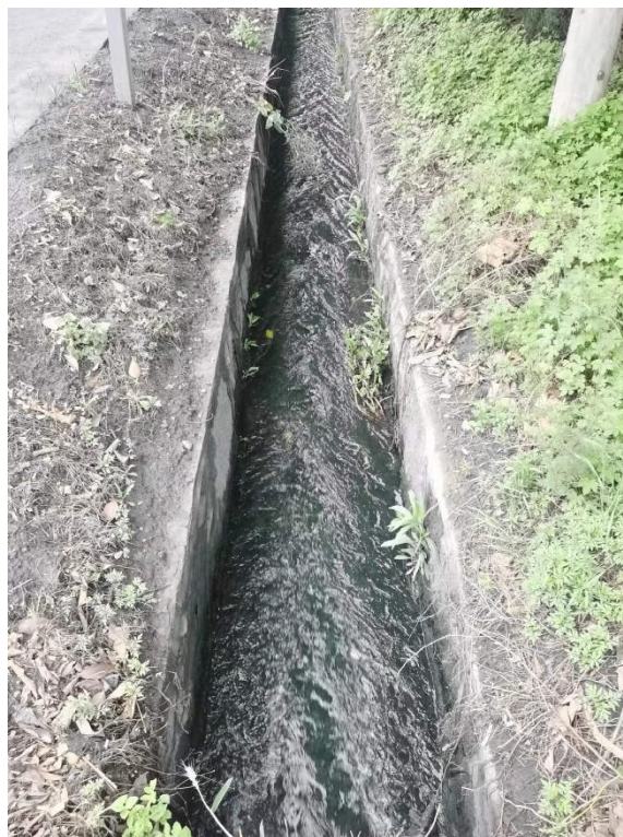
G207 道路边沟现状
