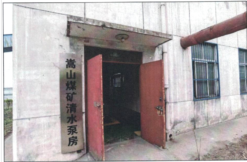
图 2.1-12 生活用水清水泵房
