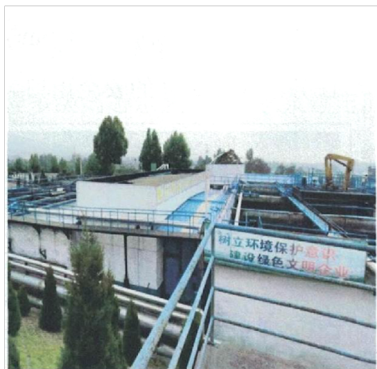
图 2.1-9 矿井水处理设施
