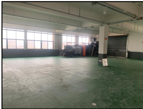
项目车间现状
