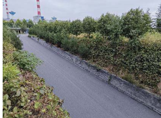
厂前道路照片
