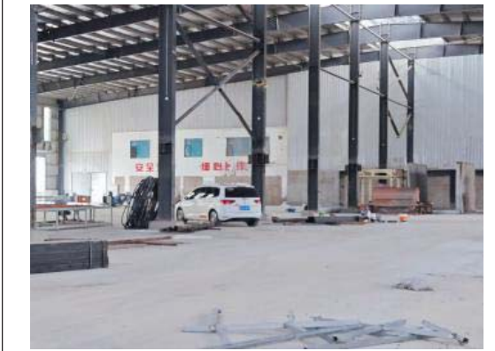
车间内现状照片
