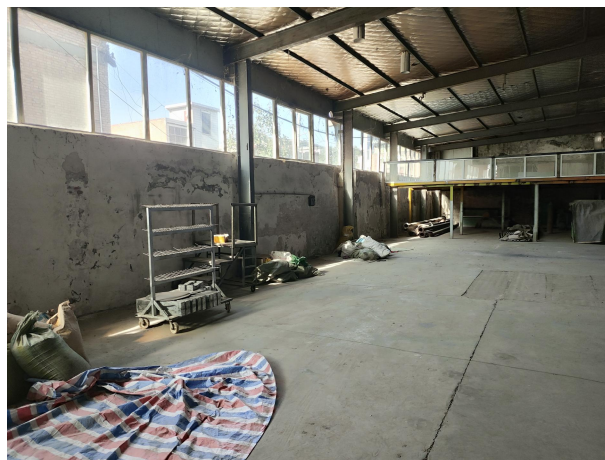
项目 2#生产车间闲置空间
