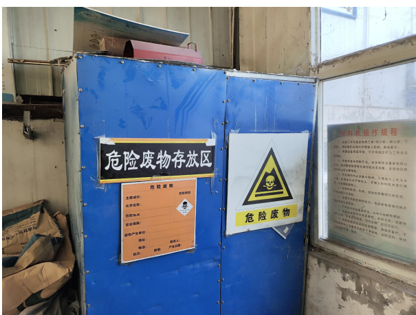
现有危废暂存间
