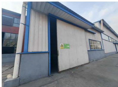
一般固废暂存间
