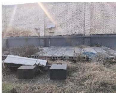
生产区一体化污水处理设施
