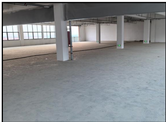
项目车间现状
