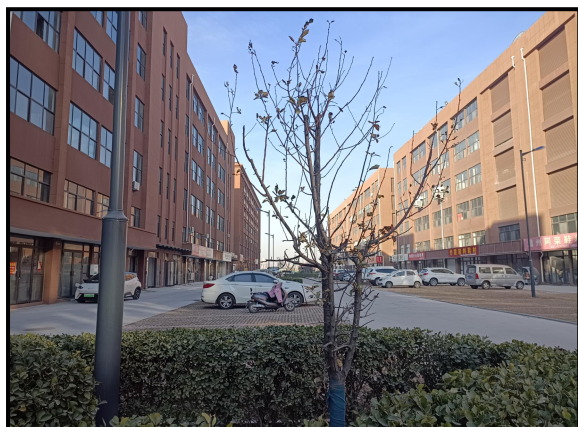
项目车间西侧园区内部道路及厂房
