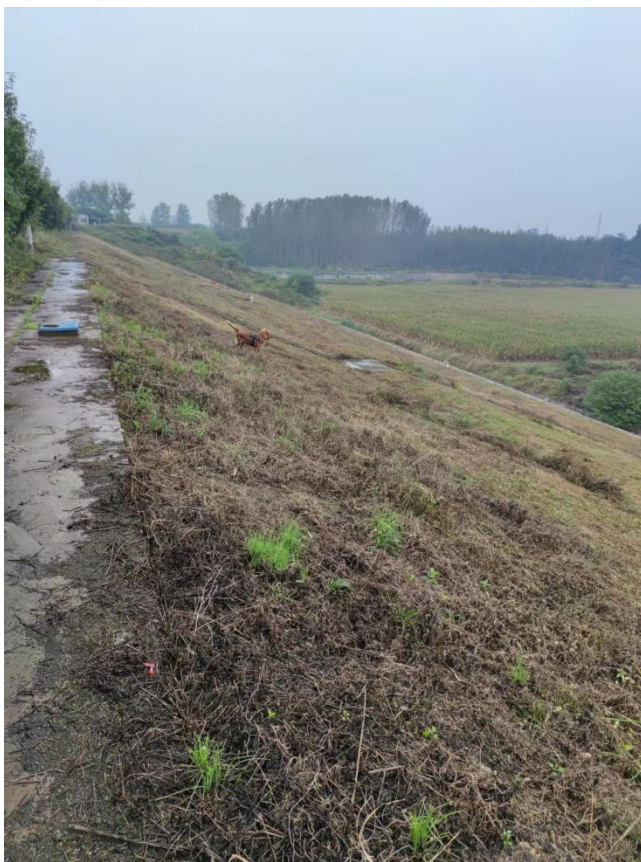
陶化店水库坝体
