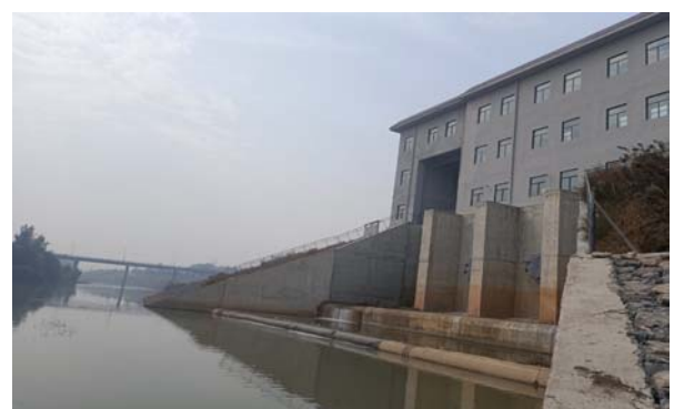
涝洼渠入伊河口
