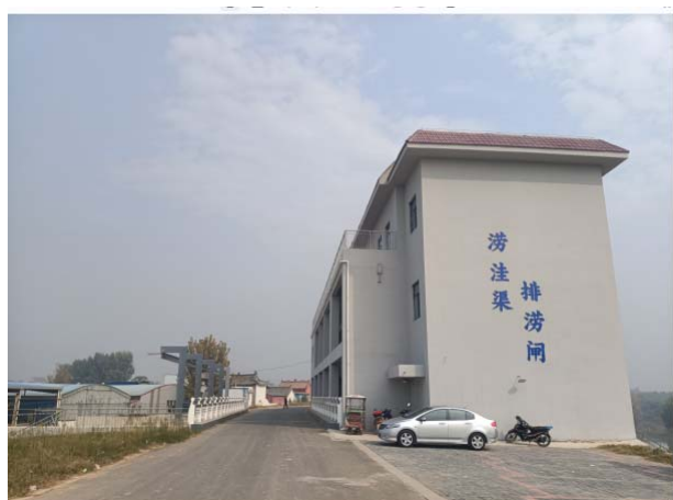
涝洼渠入伊河排水闸
