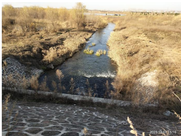
伊滨污水处理厂入河排污口
