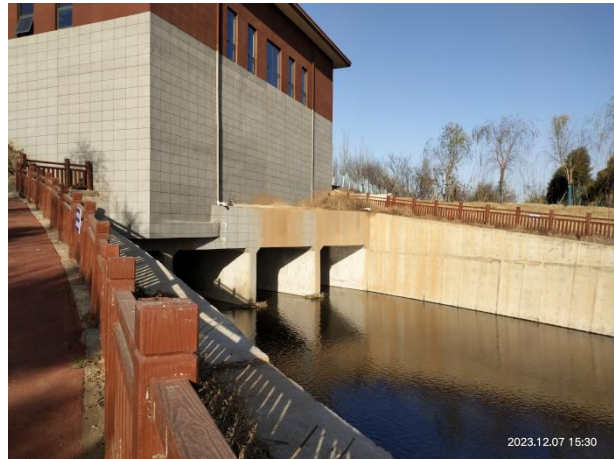
伊南排涝干渠入伊河口
