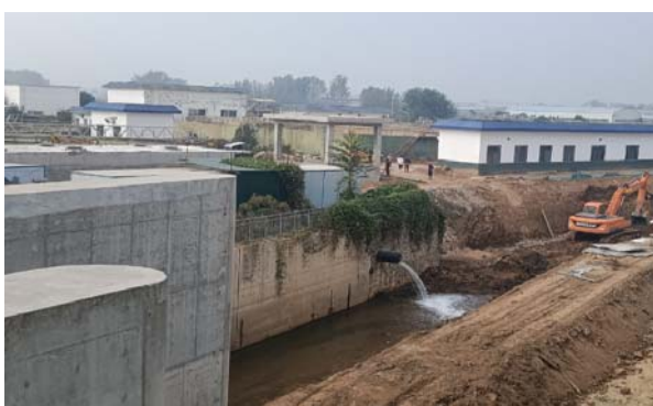
污水厂入涝洼渠排水口
