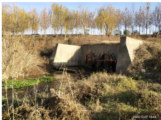
李村镇杨湾村排水口
