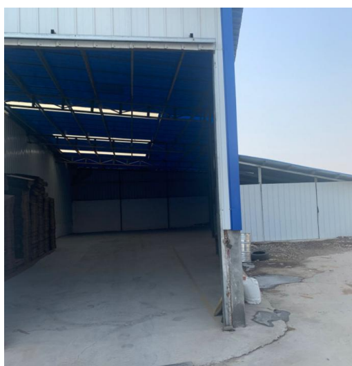
车间内部整体情况
