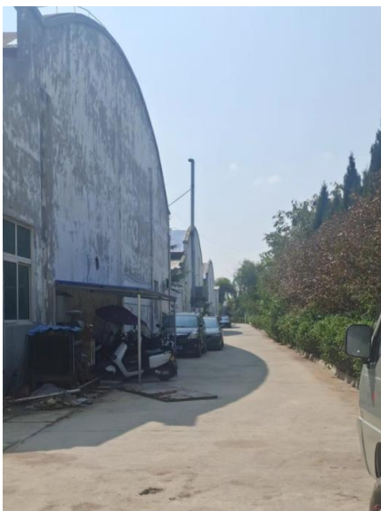
项目所在厂区东侧进厂道路
