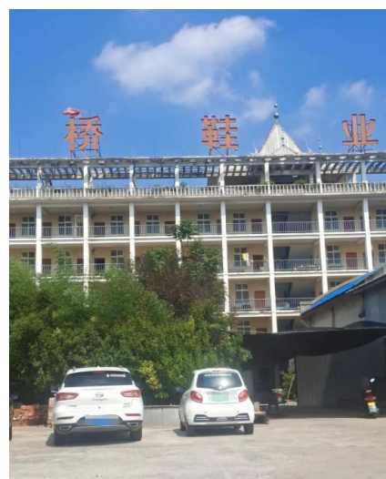
车间北侧本项目依托办公楼
