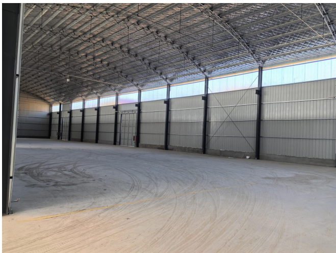
本次改建车间建设现状
