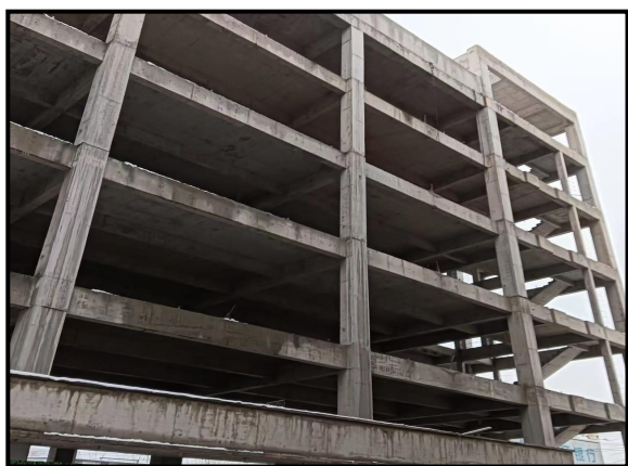
项目南侧正在施工厂房
