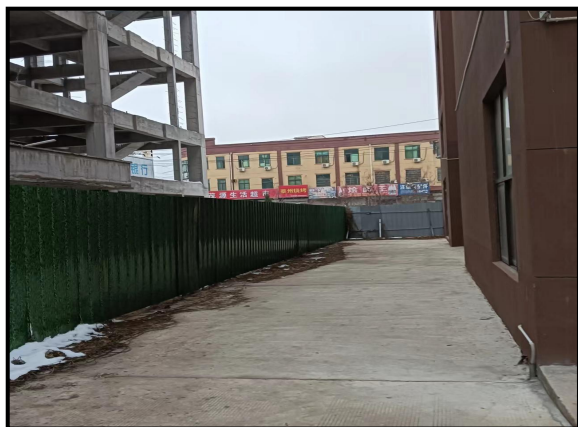
项目车间西侧园区内部道路
