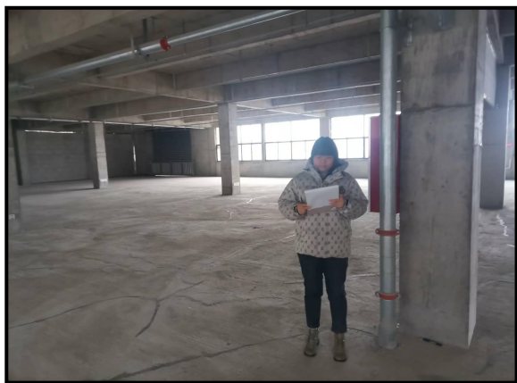
车间内（项目负责人勘察现场）
