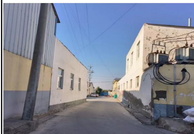
南侧同创塑料制品厂及道路
