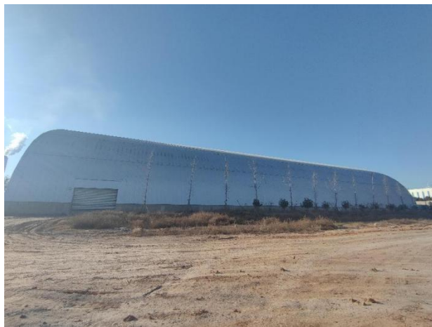
项目厂区西侧河南新时代建材厂区
