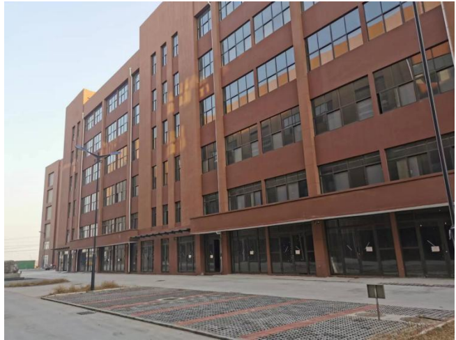
项目南侧（10 号楼）
