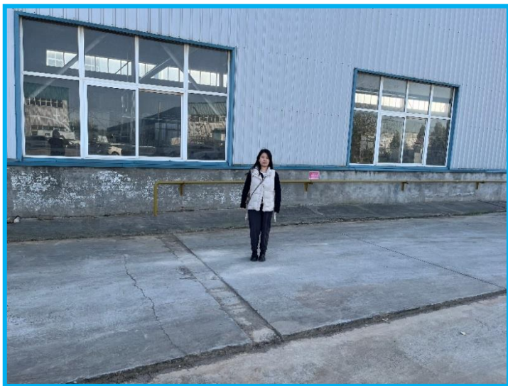
工程师现场踏勘照片
