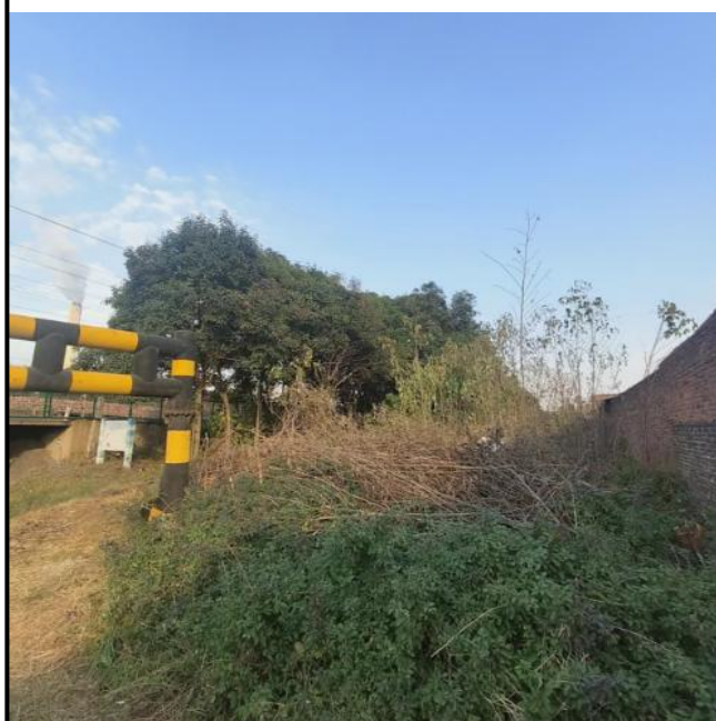
北侧陇海铁路
