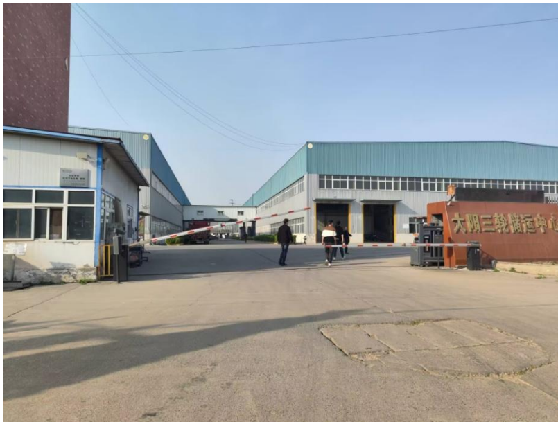
厂区入口现状
