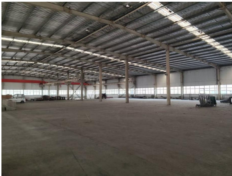
车间二层现状
