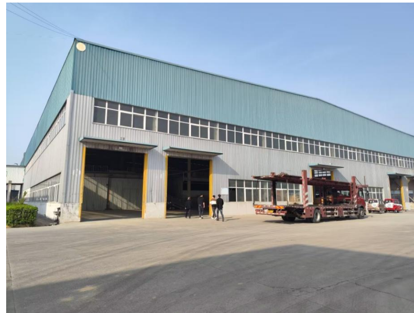
项目车间入口现状
