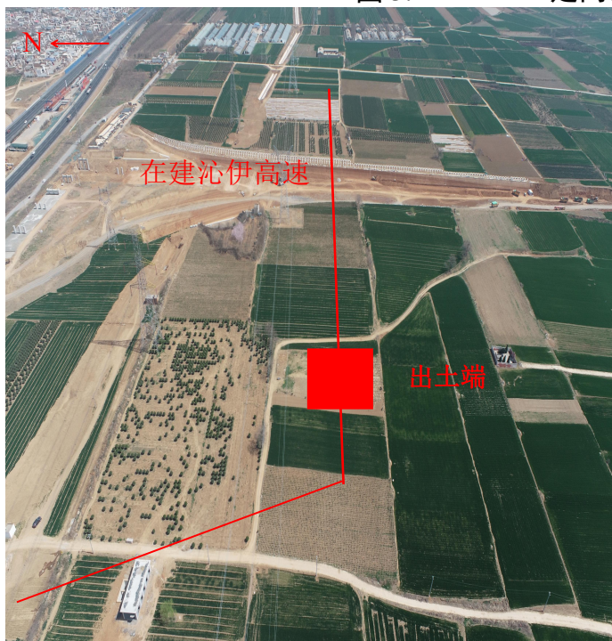
定向钻穿越出土端现状（红线为管道路由）
