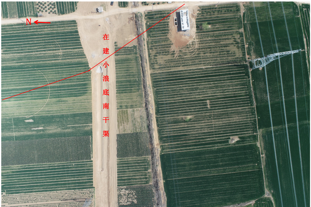
穿越小浪底南干渠现状（西段）（红线为管道路由）
