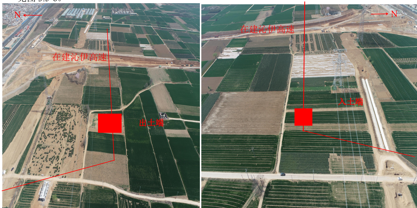
定向钻穿越出土端现状（红线为管道路由）
