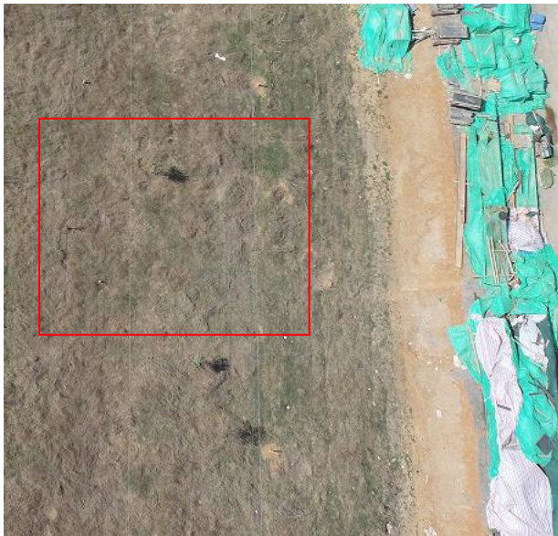
起点处动火作业区
