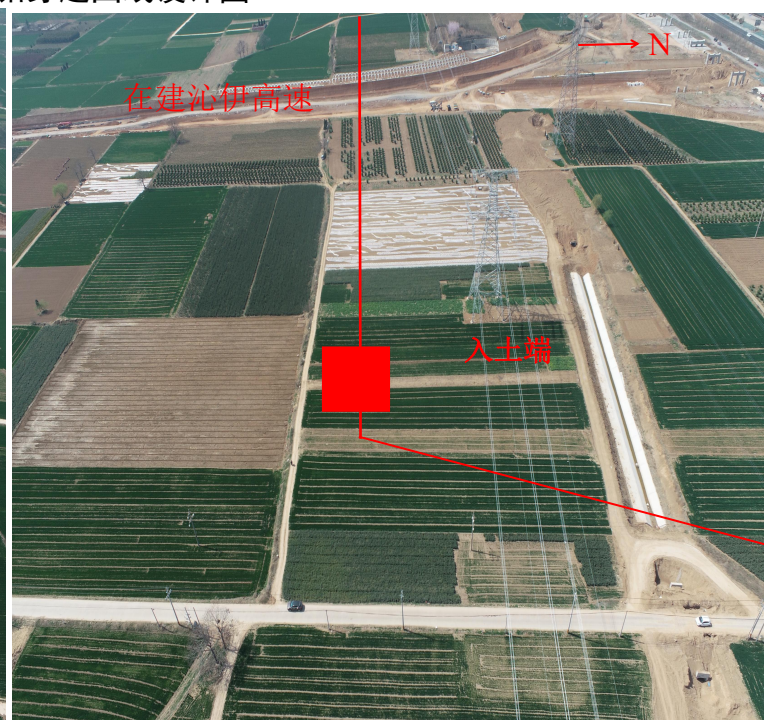
定向钻穿越入土端现状（红线为管道路由）
