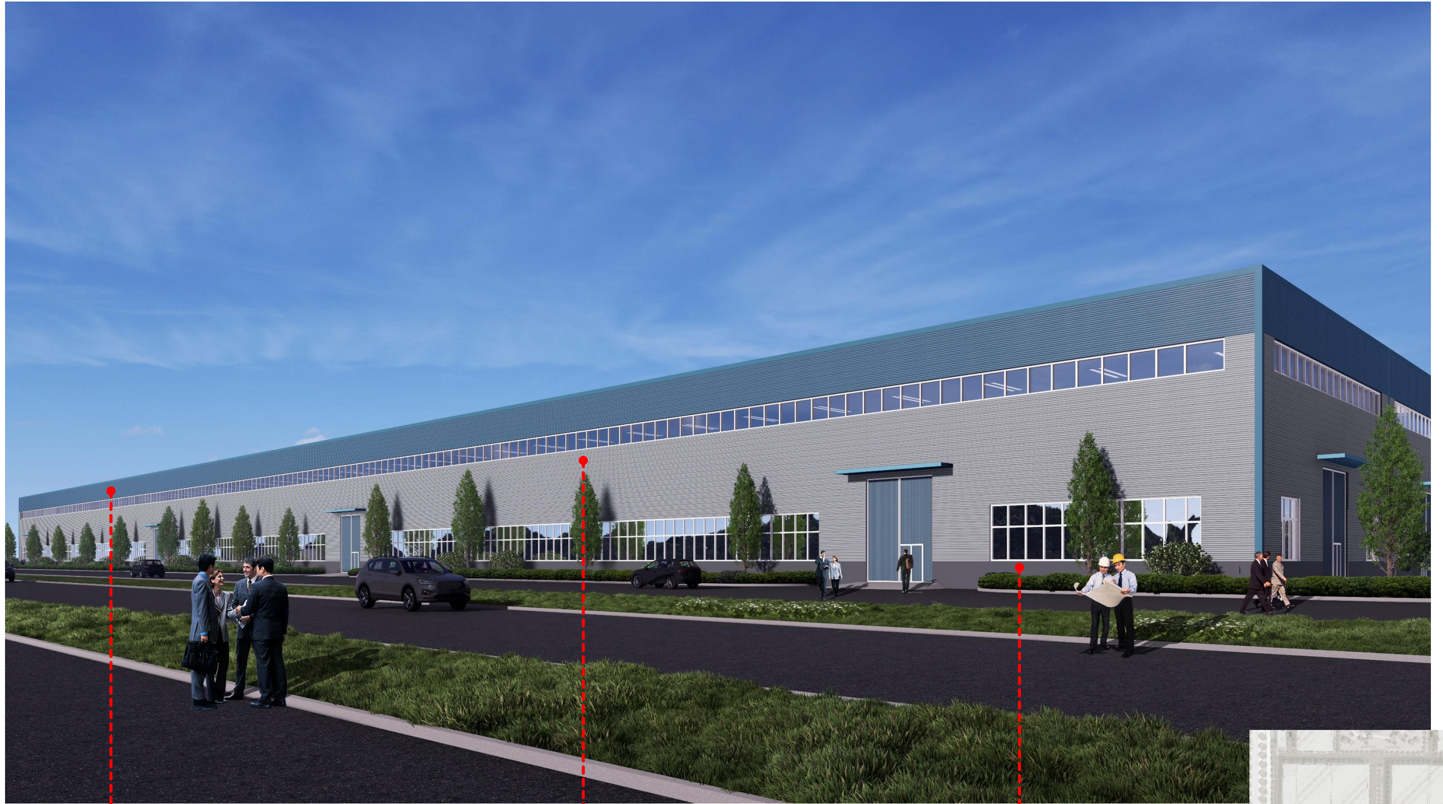
蓝色双层压型钢板复合保温墙体 CBCC中国建筑色卡 0524 (GB 1.3PB6.5/7.6)
