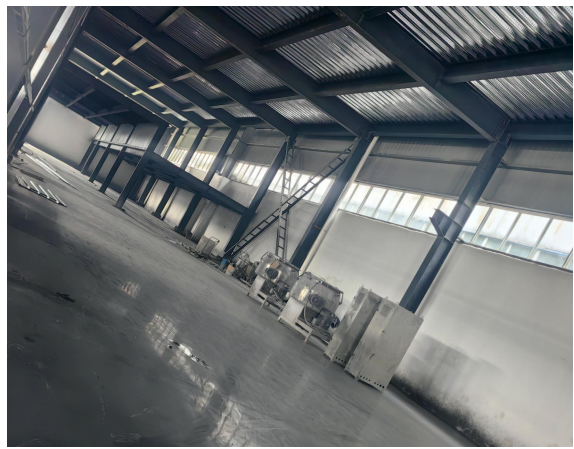
车间内部现状
