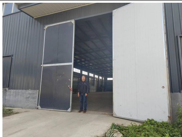
项目工程师勘查现场图
