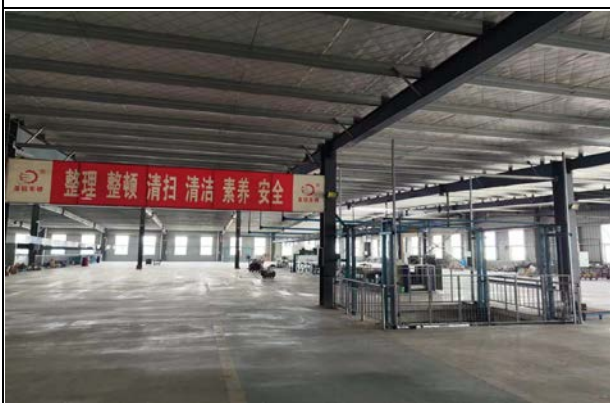
二楼车间现状
