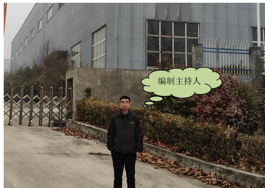
工程师现场踏勘照片
