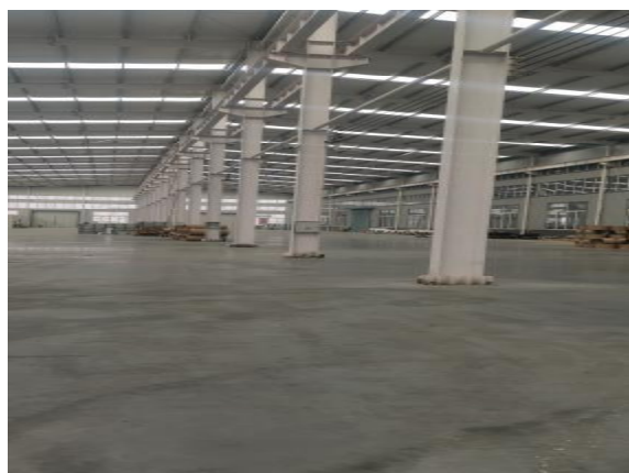
本次扩建拟利用车间概况
