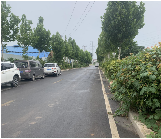
项目西侧进厂道路
