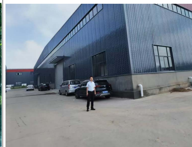
工程师现场勘察照片
