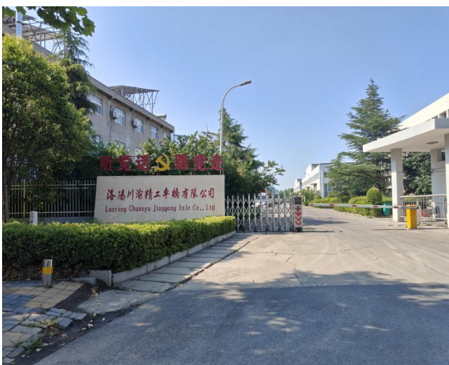
项目东侧川渝精工
