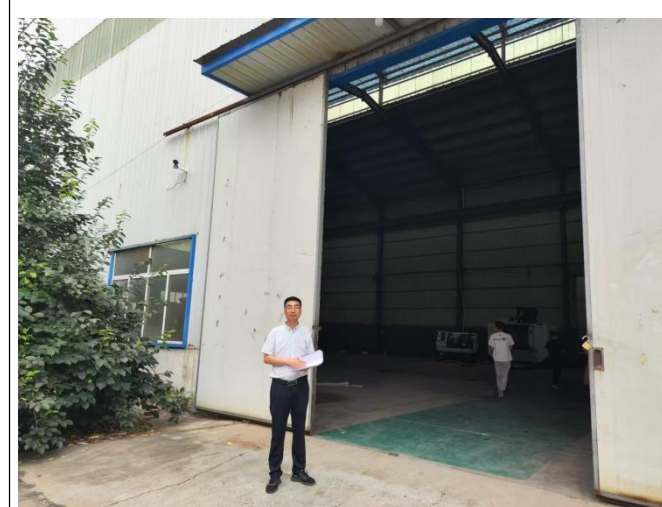
工程师现场勘察照片
