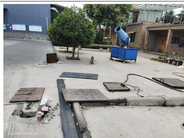
初期雨水收集池
