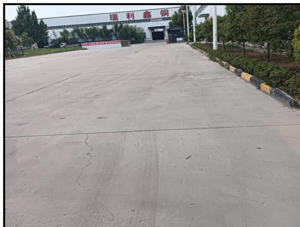
项目车间东侧厂区内道路
