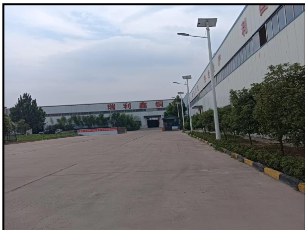
项目车间南侧瑞利鑫电缆电线有限公司
