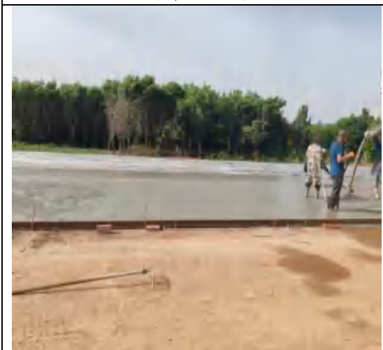
在建工程现状图
