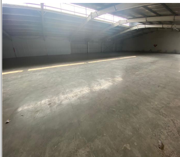
车间二楼现状
