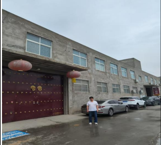
工程师勘察现场
