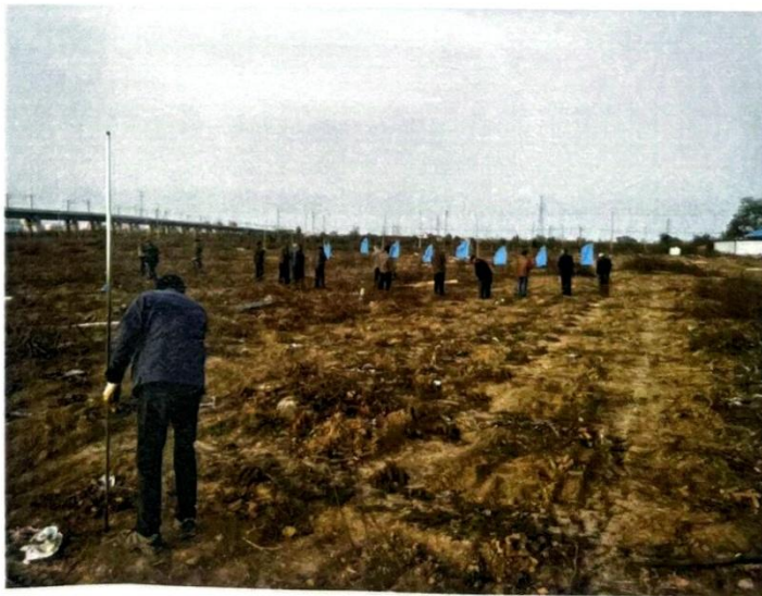
钻探作业现场
