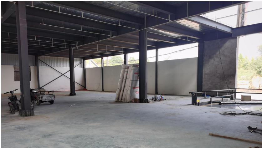
生产车间内部现状
