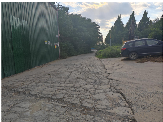
厂区南侧村道
