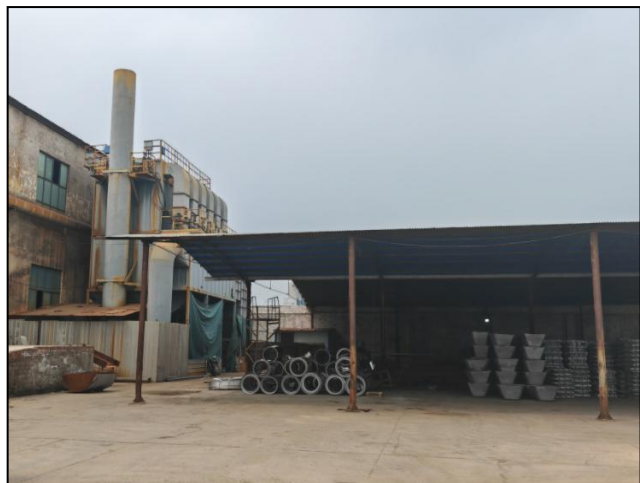
现有工程除尘设施
