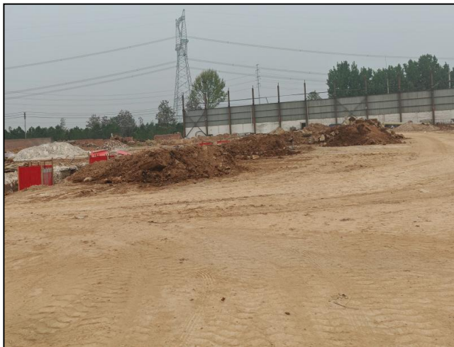
项目厂区扩建部分现状
